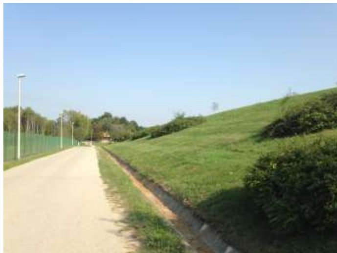
Slika 1.2./3. Obodni kanal, servisna cesta i ograda oko postojećeg odlagališta
