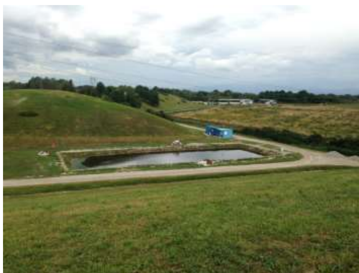
Slika 1.2./4. Bazen za procjedne vode sa nove plohe odlagališta
